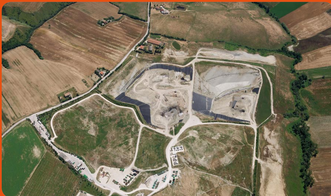
Foto 1 box 20 Vista d'insieme dell'impianto.
