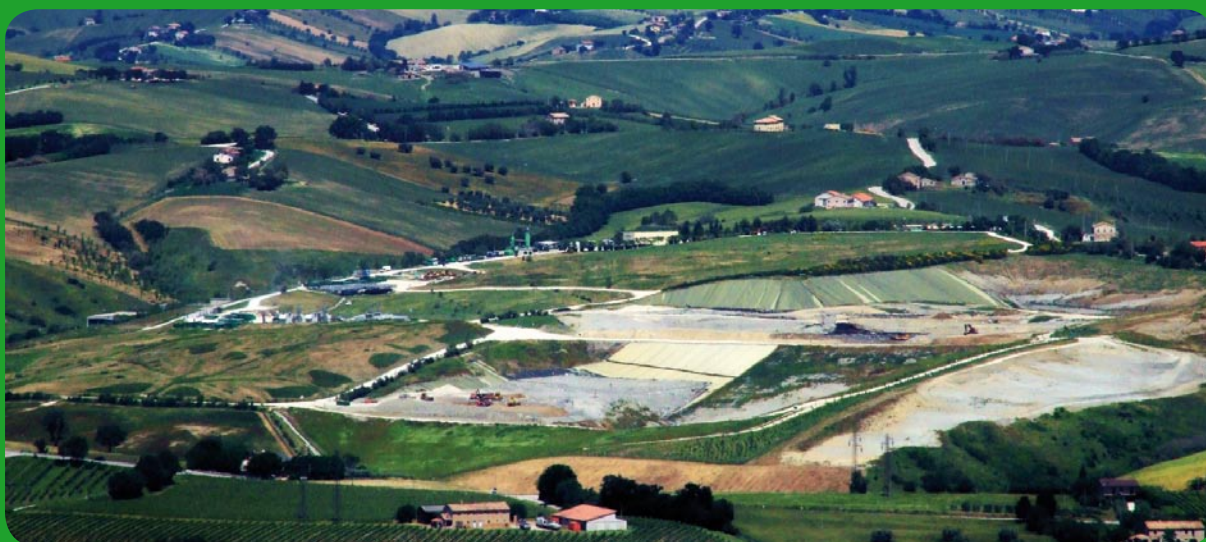
Foto 2 box 16 Riduzione dell'impatto visivo attraverso la colorazione delle guaine.
